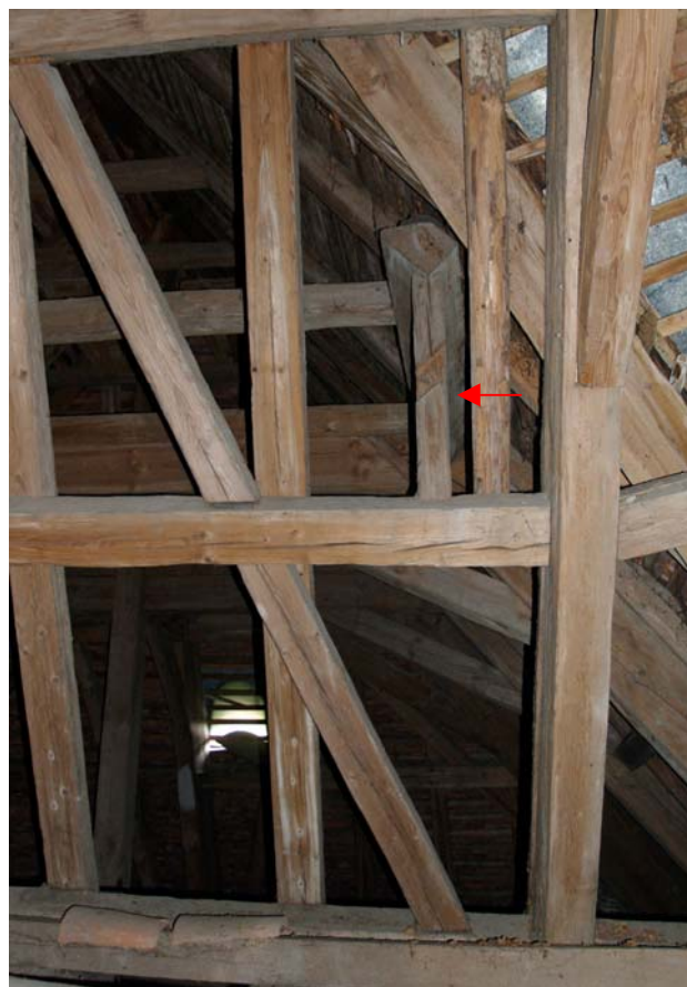
Interiéry. Krov sakristie. Krov hambalkové soustavy s ležatými stolicemi v plných vazbách je konstrukčně spojený s krovem nad chórem. Vyznačen druhotně užitý prvek ze staršího barokního krovu (dendrochronologická datace 1701+). Dole vlevo detail průřezu z chóru nad klenbu sakristie ze strany sakristie.
