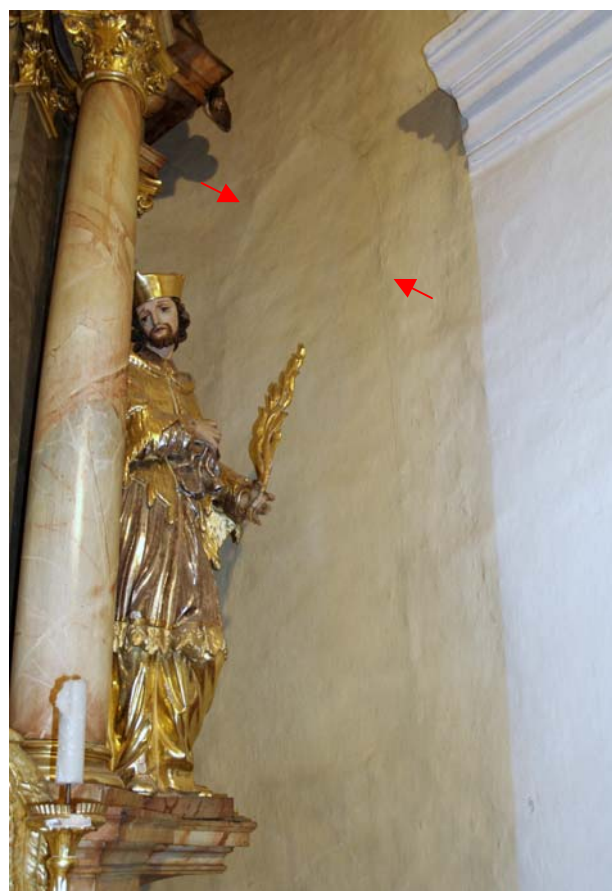
Interiéry. Loď a chór. Nahoře vlevo průhled lodí k západu ke kruchtě s varhanami z roku 1778 od znojemského varhanáře Josefa Silberbauera. Nahoře vpravo pohled k chóru. Dole vlevo hlavní oltář. Dole vpravo epištolní strana apsidy s vyznačenou spárkou v místě zazděného gotického hrotitého okna.
