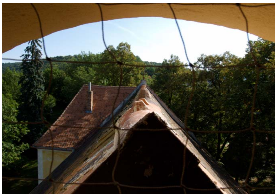
Interiéry. Věž. Nahoře vlevo západní průčelí lodi v úrovni druhého (zvonického) patra věže s průchodem na půdu kostela. Neomítané zdivo pozdně románské stavby se nad mladším průchodem zachovalo v původním stavu. Nahoře vpravo zvonová stolice s monogramem AH a letopočtem 1877 v polopatře pod úrovní korunní římsy. Dole průhled na hřeben střechy lodi.
