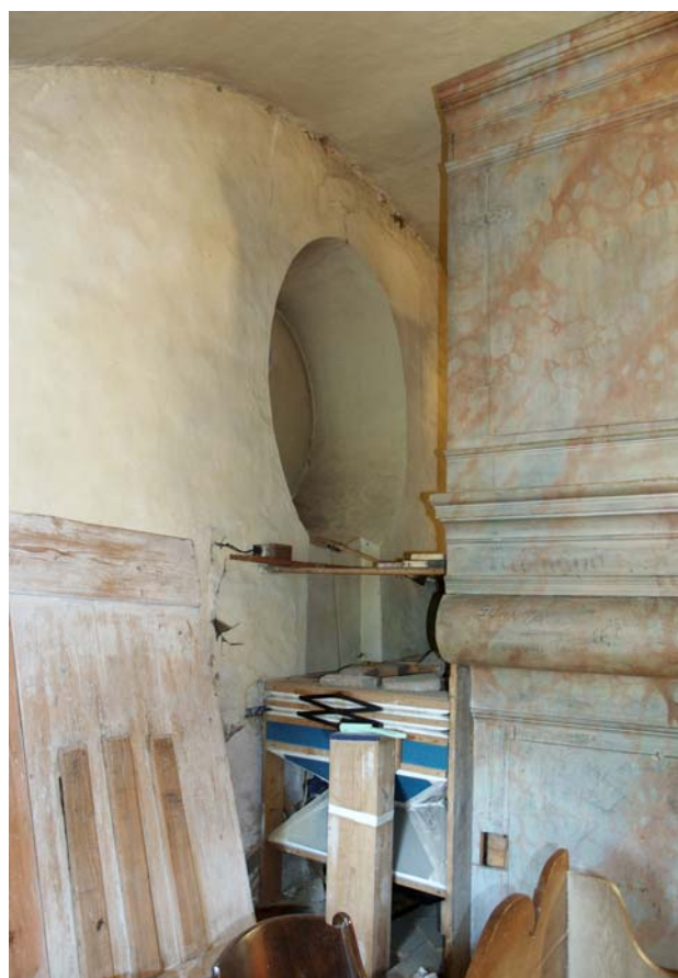
Interiéry. Věž a schodišťový přístavek u věže. Schodiště ústí ve věži v úrovni kruchty v lodi. V omítnutém západním průčelí kostela je zazděné oválné okno s omítkovou šambránou bez klenáků (dole vpravo pohled z interiéru lodi na výklenek okna za varhanami na kruchtě). Dole vlevo žebříkové schodiště ve druhém patře věže s monogramem AF a letopočtem 1877.
