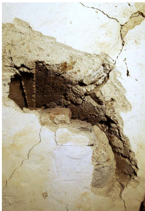
Interiéry. Půda nad lodí. Nahoře vlevo okno v jižní zdi. Nahoře vpravo a dole okna v severní zdi. Na záklenkách oken jsou otisky bednění, které nebyly nikdy překryté omítkou. Rezné lomové zdivo bylo omítnuto současně se zazdáním všech oken na severní straně lodi a jednoho okna v jižní zdi lodi.
