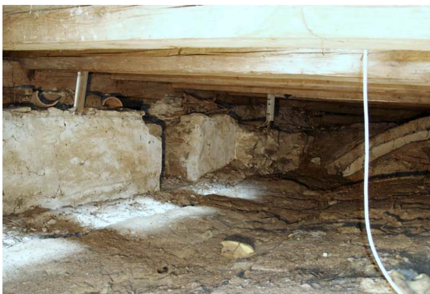
Interiéry. Půda nad chórem. Nahoře nápis uhlem na východním štítu s datem 14. 9. 1897. Uprostřed omítka na severní straně triumfálního oblouku se stopami červeného nátěru. Dole pohled na severní stěnu chóru s otvorem průlezu do podkroví sakristie.
