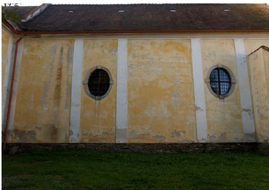
Průčelí. Severní průčelí sakristie a lodi. Uprostřed detail římsy v místě pravoúhlého odsazení severní zdi sakristie. Do barokní přestavby kostela uzavírala sakristii odsazená apsida ( srov. příloha 10 – 13 ).
