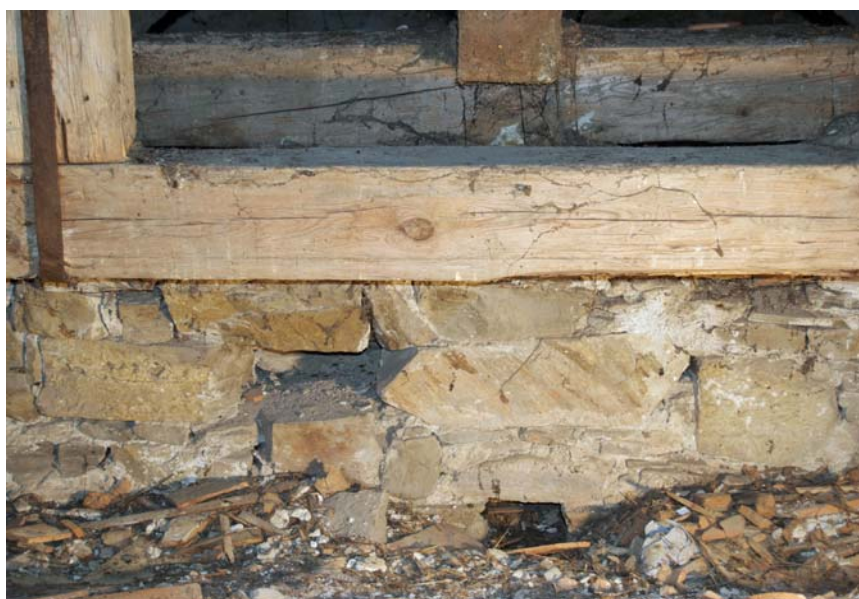
Interiéry. Půda nad sakristií. Severní zeď chóru ze strany sakristie. Nahoře pohled na východní část vlevo od průlezu. Trámová kapsa dole se nachází pod úrovní vrcholnice valené klenby sakristie.
