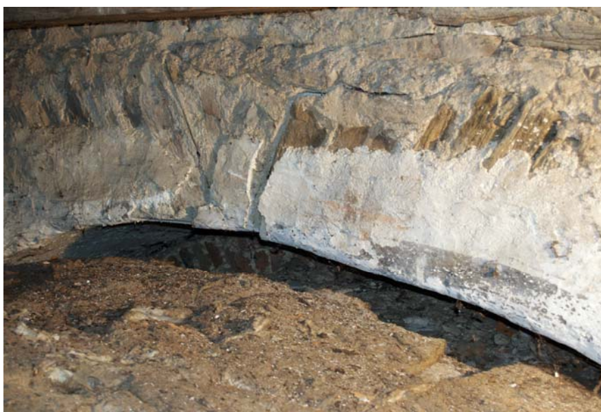
Interiéry. Půda nad lodí. Nahoře okno v jižní zdi s malovanou paspartou rámovanou linkou. Uprostřed detail okraje omítky na východním štítu ze strany lodi ve výši původního stropu. Dole pozdně románský triumfální oblouk ze strany půdy nad chórem.
