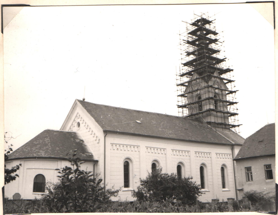
Po opravě kostela. Lešení kolem věže, která se opravuje.
