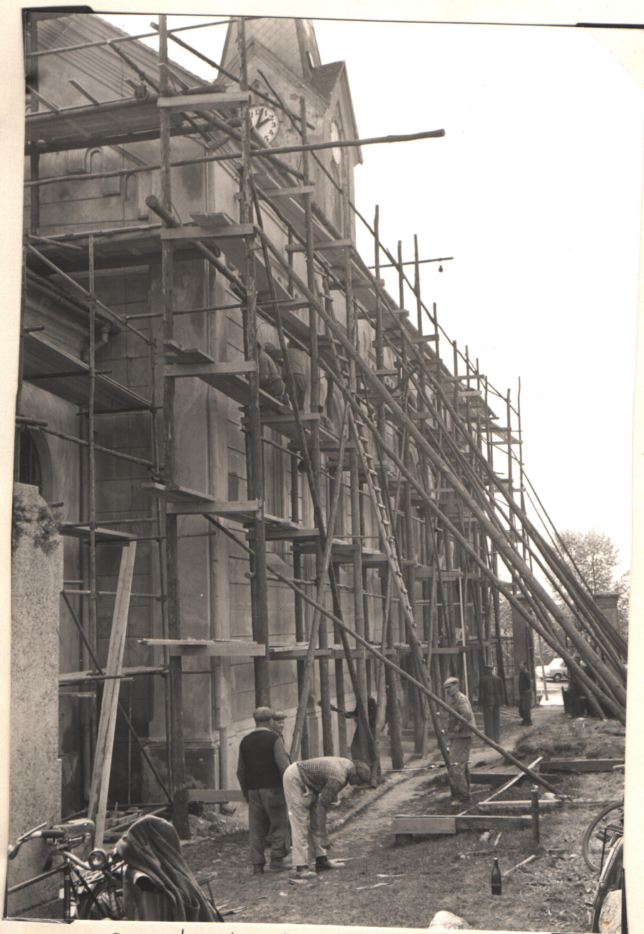
Severní část kostela při opravě.
