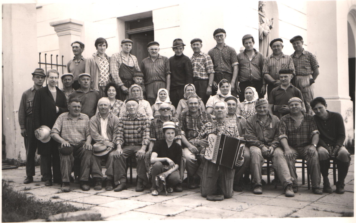
Část brigádníků při opravě stíchy kostela.
