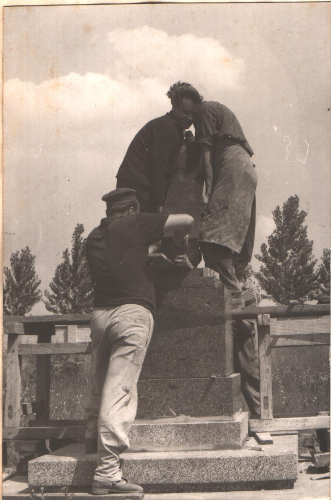
Stavba hlavního kříže na hřbitově.
