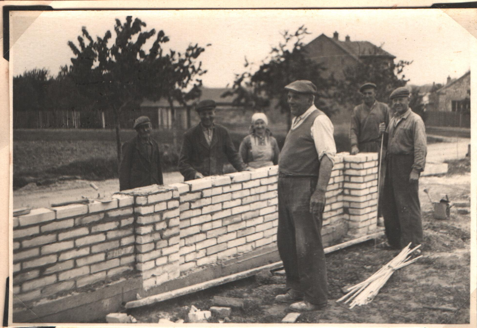
Zahájení stavby zdi
