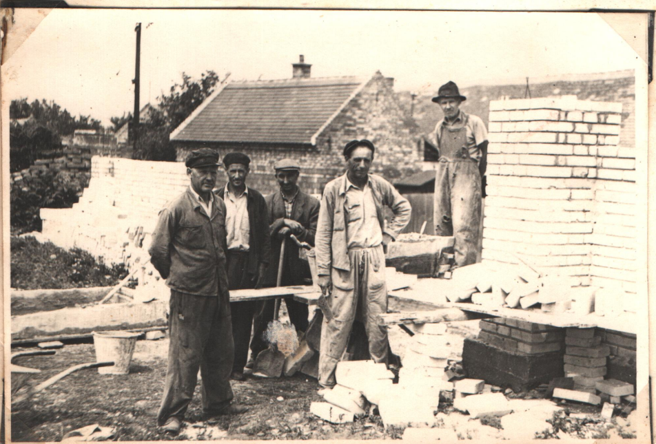
Práce na ukončení stavby
